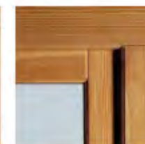
Détail de finition d'assemblage.
