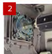
2 Système anti-chute du tablier.
